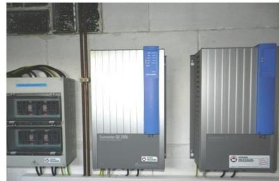
Die Technik im Keller von Oma und Opa Pfisterer. Die beiden Wechselrichter der Firma Mastervolt sind im Juni sieben Jahre ohne Probleme in Betrieb.
