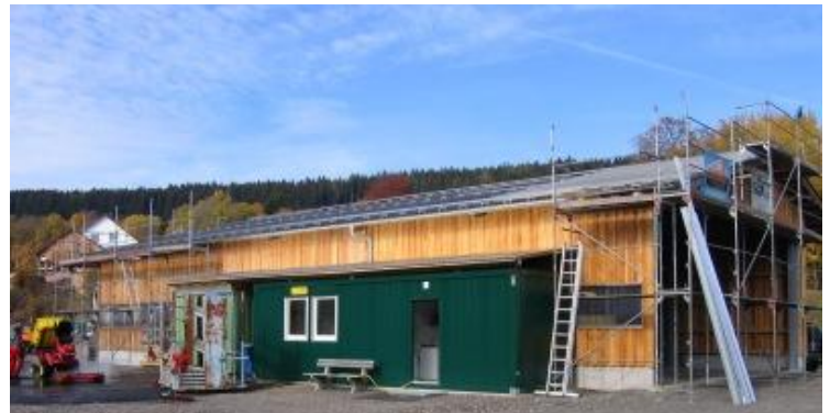
Im Bau die PV-Anlage der BELeG auf dem Dach der Maschinenhalle der Fa. Metzger in Raitenbuch.
